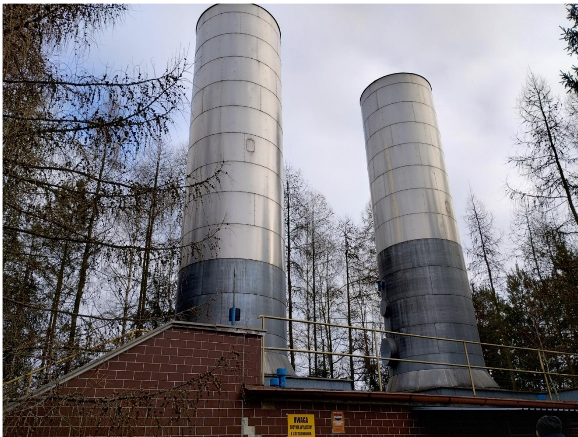
Widok ogólny budynku wraz z elektrofiltrami
