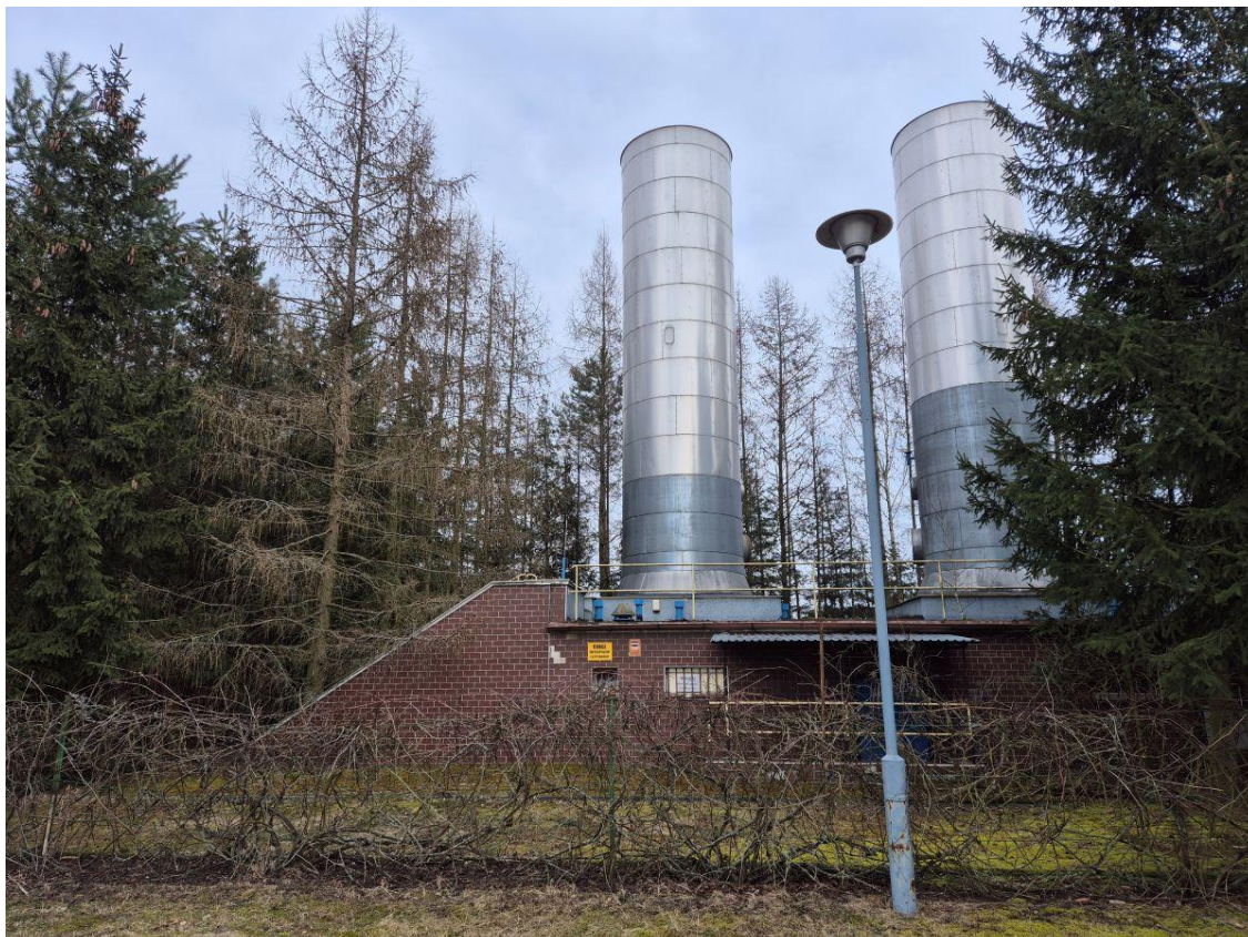
Widok ogólny budynku wraz z elektrofiltrami
