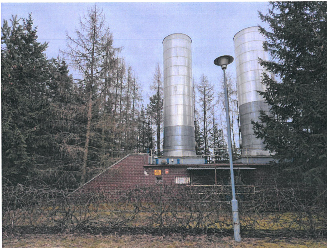
Zdj. 1. Widok ogólny budynku wraz z „Hydrofiltrami 60Mx2”.
