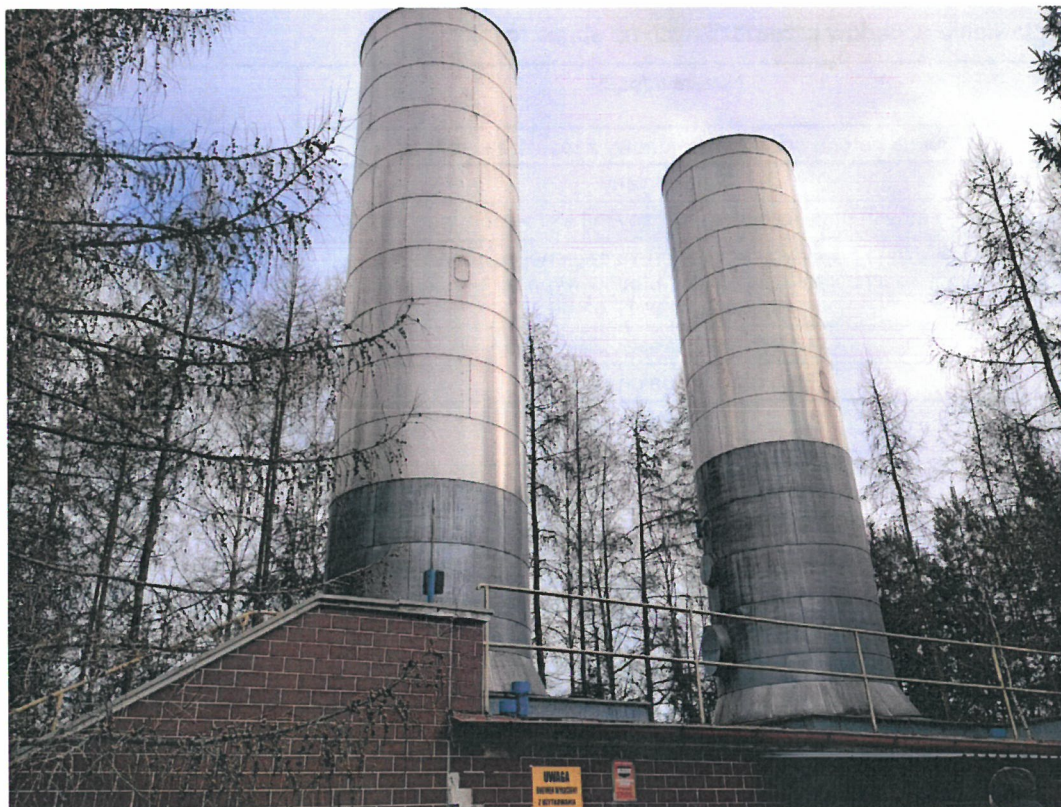
Zdj. 2. Widok ogólny budynku wraz z „Hydrofiltrami 60Mx2”.
